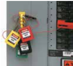
4. Para bloqueos grupales, pase la llave por múltiples aros en el riel de bloqueo y aplique los candados. No se requieren broches. (No se recomienda para uso con broches de bloqueo múltiple.)
