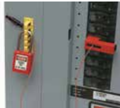
3. Pase la llave de plástico a través del riel para bloqueo y coloque el candado, evitando que la llave se deslice hacia abajo y que se abra el dispositivo.
