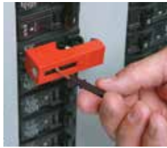
El dispositivo se desbloquea insertando y girando la llave negra de plástico.
