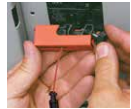
2. Coloque el dispositivo de bloqueo en el interruptor y póngalo en posición de bloqueado.
