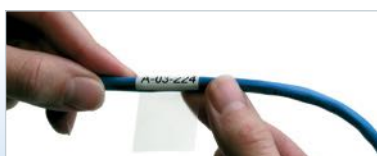
Envolver la etiqueta alrededor del cable con la zona transparente, cubriendo la zona impresa.
