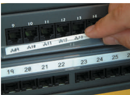
Labels voor aansluitklemmen en patchpanelen
