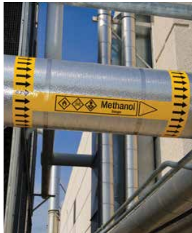
Marquage de tuyauteries
