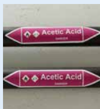
Marquage de tuyauterie
