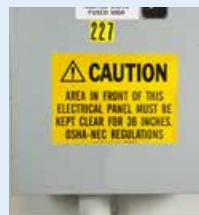
Panneaux de danger
