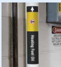
Marquage de tuyauterie
