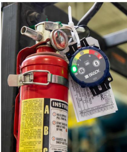
Der innovative Inspektionstimer von Brady kann Leben retten, da er deutlich anzeigt, wann Maschinen, Geräte und Werkzeuge gewartet werden müssen. Die LED-Anzeigen sind auch aus einer größeren Entfernung für Bediener und Wartungstechniker deutlich sichtbar. So wird die Nutzung von abgenutzten oder nicht geprüften Ausrüstungsgegenständen verhindert.
