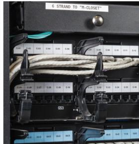
etiquetas para bloques de cableado
