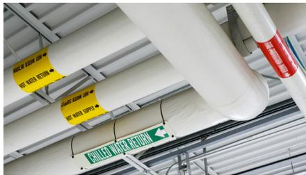
**Marcaje de tubería**
