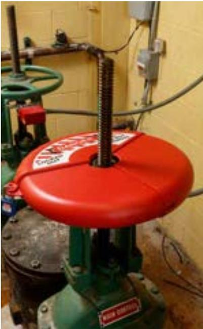
Brady bietet zusammenklappbare Vorrichtungen, die ein sicheres Absperrern verschiedenster Durchgangsventile ermöglichen, sodass weniger Vorrichtungen erforderlich sind. Diese Absperrvorrichtungen lassen sich ganz einfach an Ventilgriffen in der vollständig geschlossenen Position anbringen. Sie können aber auch zusammengeklappt werden, sodass sie auf Wartungswagen und in Lockout-Sets weniger Platz in Anspruch nehmen.
