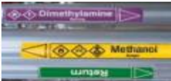
Marcado de tuberías y válvulas
