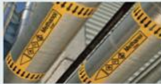
Marcado de Tuberías
