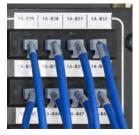
Ces étiquettes sont prévues pour être imprimées, coupées à la longueur désirée et servir de bandes insérables pour les panneaux de connexion voix/données. Elles offrent une lisibilité optimale et se montrent très solides.
