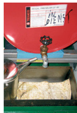
Oil Plus-doeken onder lekkende oliekannen en vaten.
