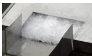
Filtratie van het afvalwater alvorens het wordt afgevoerd naar het afwateringsgebied.
