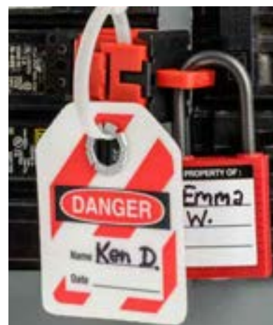
Beveiliging met kabelbinder en/of hangslot
