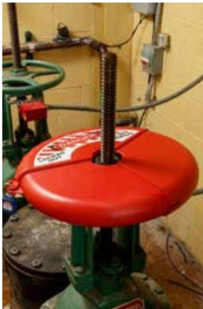
Les systèmes de condamnation de vannes à volant rétractables Brady permettent de condamner un plus large éventail de vannes avec moins de dispositifs. Ils peuvent facilement pivoter autour des poignées de vanne en position d'utilisation, mais aussi se replier dans un format compact pour faciliter le stockage sur les chariots de maintenance et dans les kits de condamnation/consignation.
