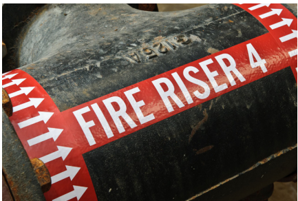
Nhãn đánh dấu đường ống
