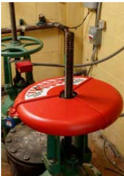
El diseño de válvulas con volante plegables de Brady ofrece un bloqueo seguro para una mayor variedad de válvulas, mediante el uso de menos dispositivos. Estas cubiertas rotan fácilmente alrededor de las manetas de las válvulas hasta la posición de accionamiento completo, a la vez que se pliegan en tamaños más compactos para un sencillo almacenamiento en las carretillas de mantenimiento y en los kits de bloqueo.
